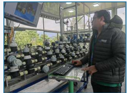
Fotografías tomadas durante la visita presencial
